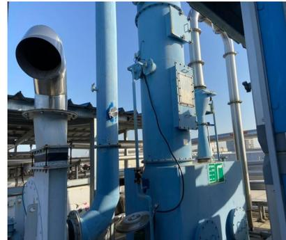
图4-6 2#排气筒（布袋除尘+水喷淋）
