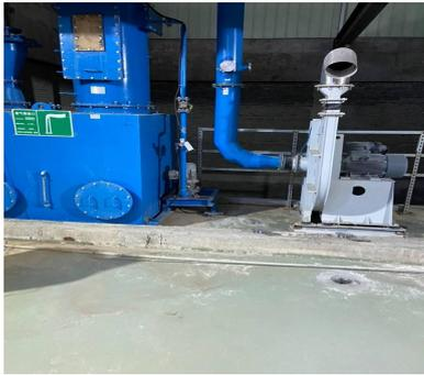
图4-5 1#排气筒（布袋除尘+水喷淋）
