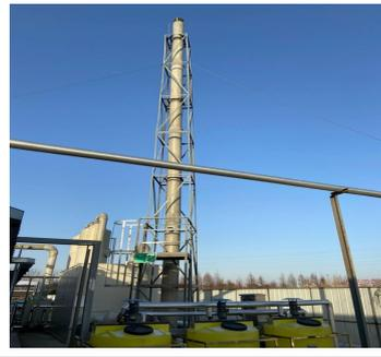
图4-18 14#排气筒（二级水喷淋+生物滤池）
