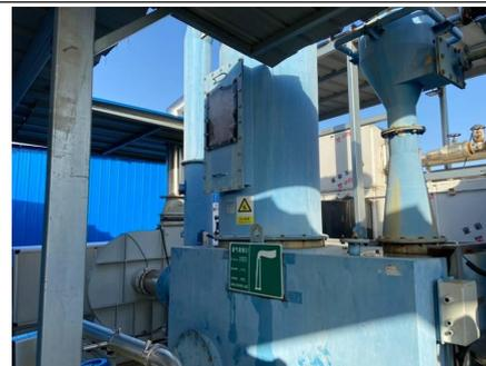
图4-8 4#排气筒（布袋除尘+水喷淋）
