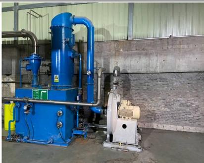
图4-7 3#排气筒（布袋除尘+水喷淋）
